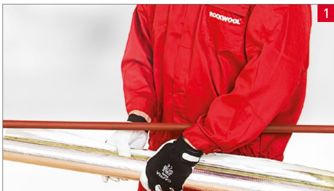
Jednoduché nasadenie puzdra na potrubie
