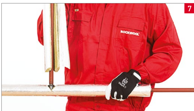
Jednoduchá izolácia T-spoja – nasadenie koliená na zvislú časť
