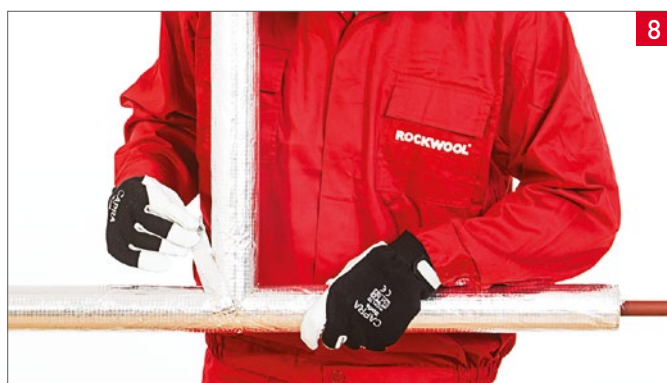
Prelepenie spojov hliníkovou páskou
