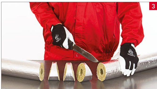
Ukážka rezania jednotlivých segmentov kolien
