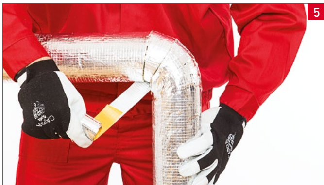
Prelepenie spojov koliená hliníkovou páskou
